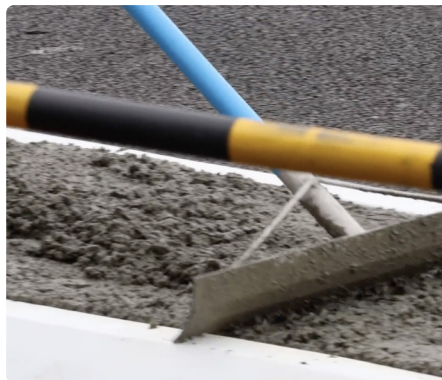
▲ Pour concrete into cavity
